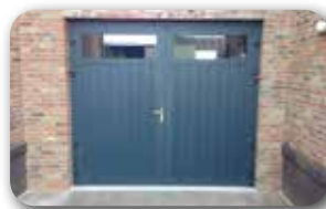
horizontaal geplaatste glasstrook in verticaal geprofileerde deur
