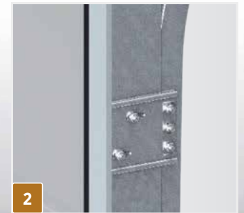
Looprails vastgeschroefd aan het frame
